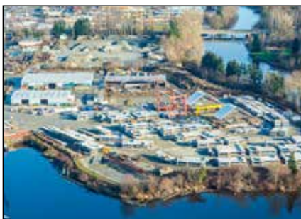
Kenmore construction site
