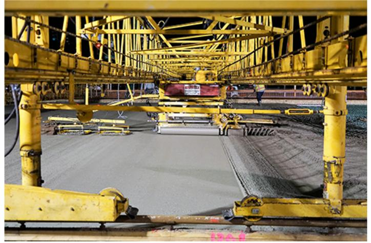
작업반이 대형 교량 바닥판 포장 장비를 사용하여 SR 520 도로 위에 건설될 Montlake lid 용 콘크리트 포장 중. Lid 내 동 구간에 대한 6 차레 야간 콘크리트 붓기 작업 중 첫 번째에 해당. 우측: Montlake lid 콘크리트 붓기 작업에 사용된 장비의 또 다른 전경.
