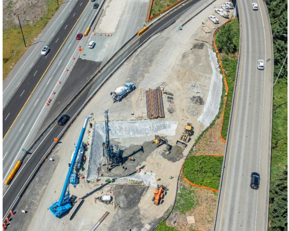
Looking west, the new Par Creek fish passage under SR 522
